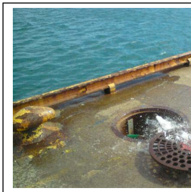
Forbedringspotensialer, beskyttelse av tappestusser mot skadedyr/fugl
