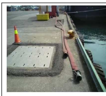
Forbedringspotensialer, beskyttelse av tappestusser mot skadedyr/fugl
